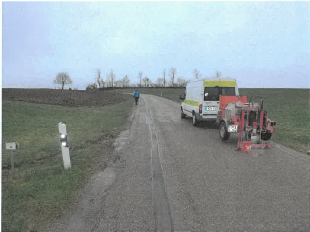
Bild 7 : Entnahmestelle Bohrkern N2 (0,400 li)
