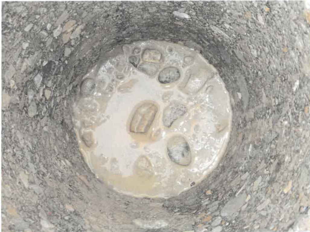
Bild 15 : Bohrloch von Bohrkern N4
