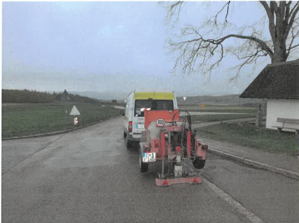
Bild 1 : Entnahmestelle Bohrkern N0 (0,040 li)
