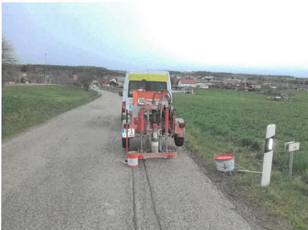
Bild 10 : Entnahmestelle Bohrkern N3 (0,600 re)
