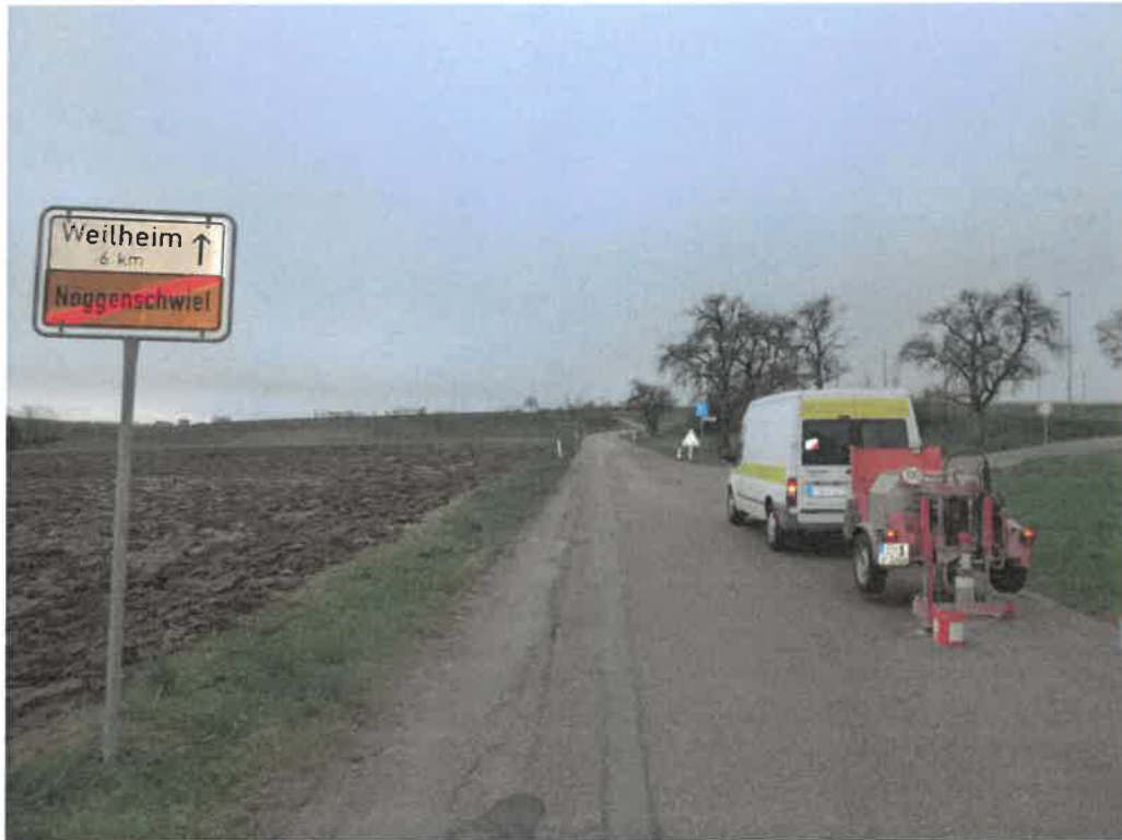
Bild 13 : Entnahmestelle Bohrkern N4 (0,775 li)
