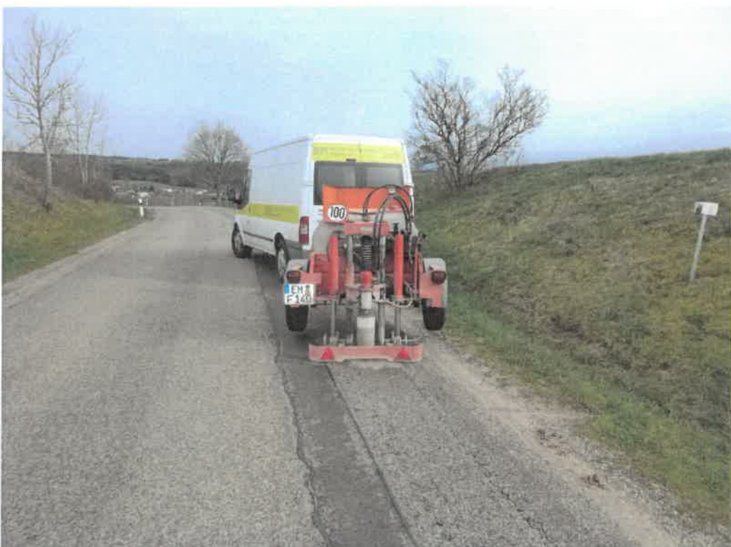
Bild 4 : Entnahmestelle Bohrkern N1 (0,200 re)
