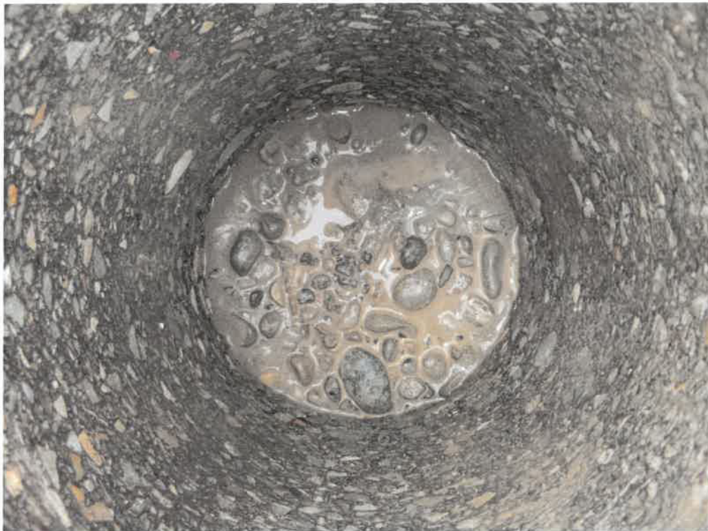
Bild 3 : Bohrloch von Bohrkern N0
