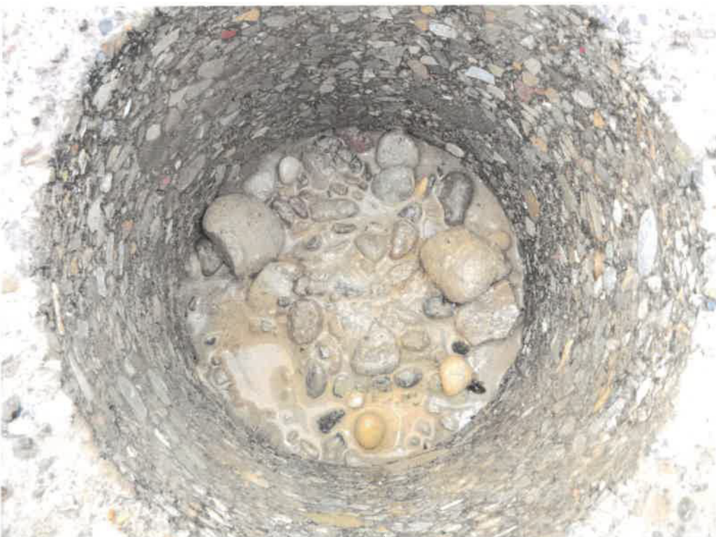
Bild 12 : Bohrloch von Bohrkern N3
