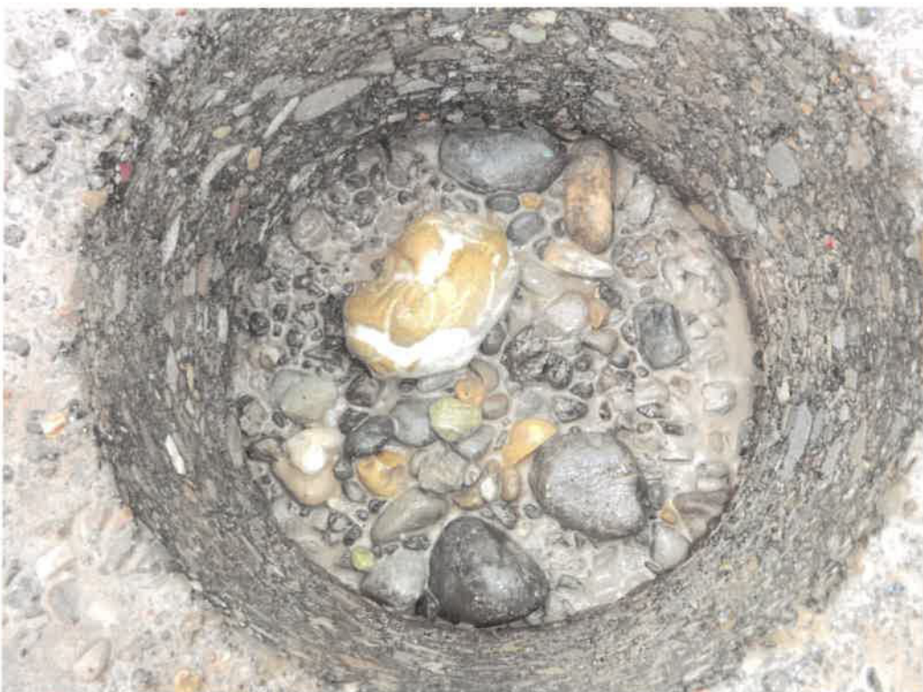
Bild 6 : Bohrloch von Bohrkern N1
